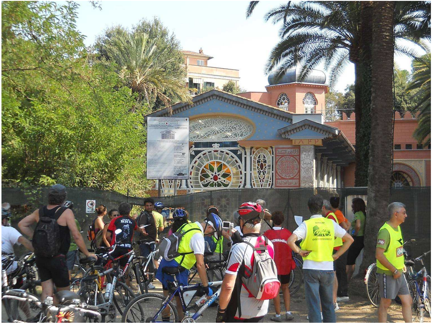
... la Torre Moresca, in fase di restauro, con la sua serra...
