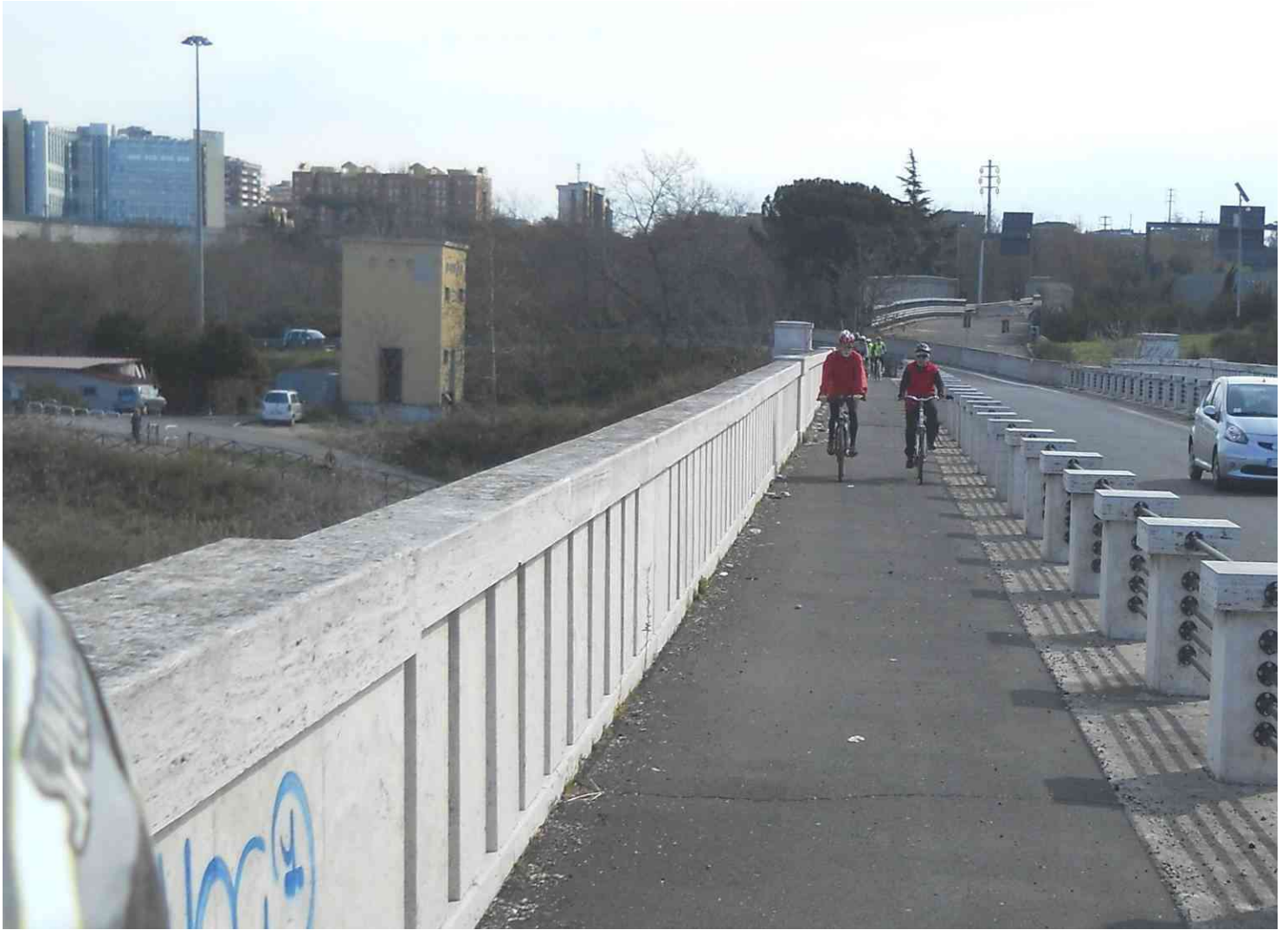
Il ponte sul Tevere del GRA ha questo percorso "protetto"...
