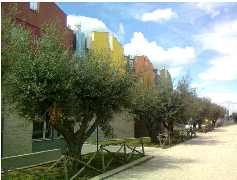
Case Isveur Passarelli, cortile interno.
