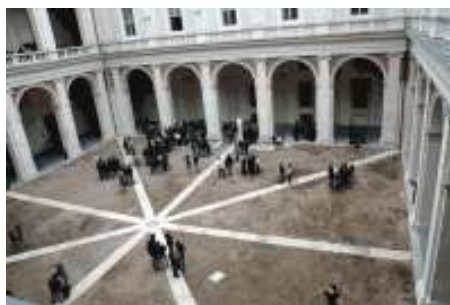
Il cortile del Visconti dopo il recente restauro
